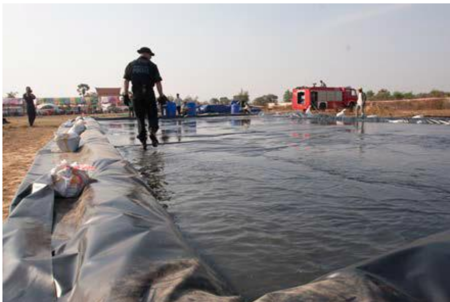
Figura 8. Colocación de cubierta plástica en el dique de evaporación. (Fuente: Guía ilustrada para la Eliminación de las sustancias químicas utilizadas en la fabricación ilícita de drogas, UNODC).
