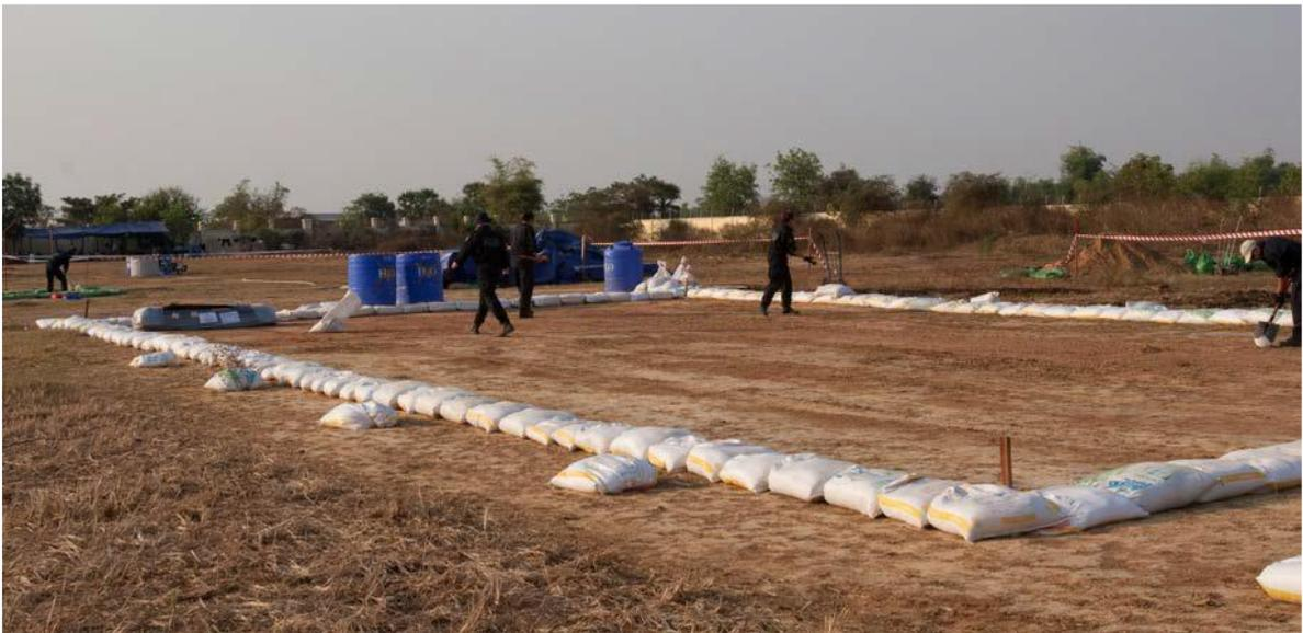
Figura 7. Dique de evaporación con costales de arena. (Fuente: Guía ilustrada para la Eliminación de las sustancias químicas utilizadas en la fabricación ilícita de drogas, UNODC).
