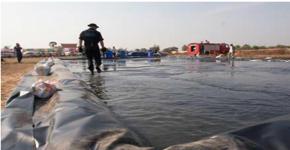
Figura 8. Colocación de cubierta plástica en el dique de evaporación. (Fuente: Guía ilustrada para la Eliminación de las sustancias químicas utilizadas en la fabricación ilícita de drogas, UNODC).
