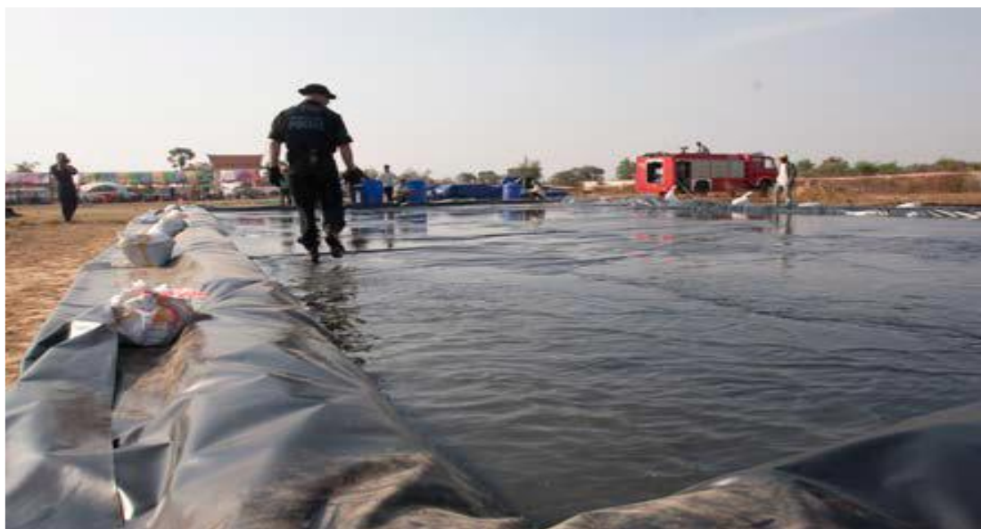
Figura 8. Colocación de cubierta plástica en el dique de evaporación. (Fuente: Guía ilustrada para la Eliminación de las sustancias químicas utilizadas en la fabricación ilícita de drogas, UNODC).
